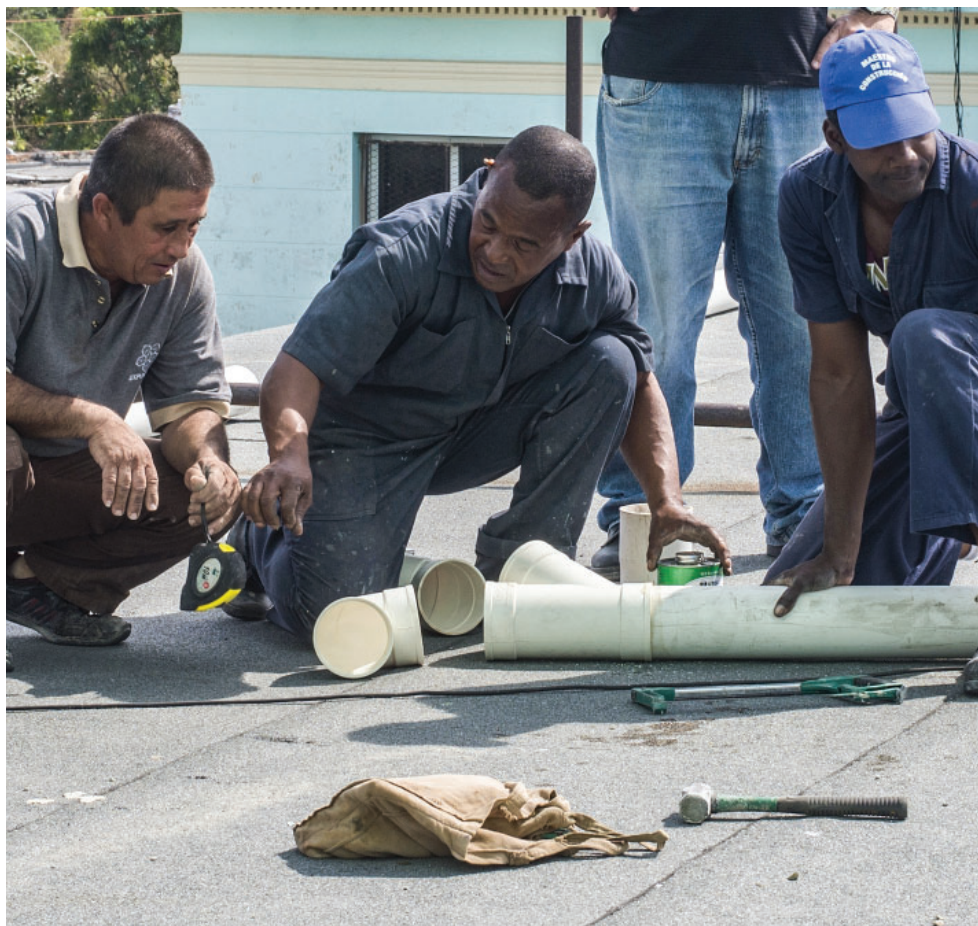
Labor de los constructores en uno de los municipios afectados.
